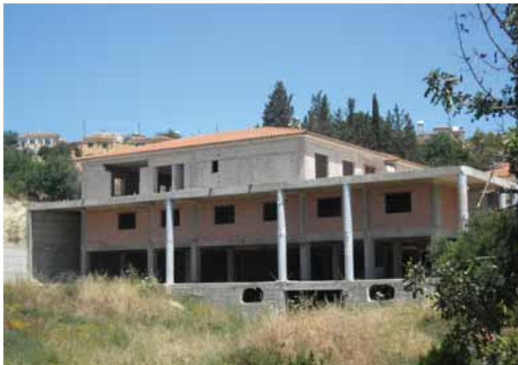
● Το υπό ανέγερση Κέντρο Ανακουφιστικής Φροντίδας (Hospice) στο Μέσα Χωριό.
